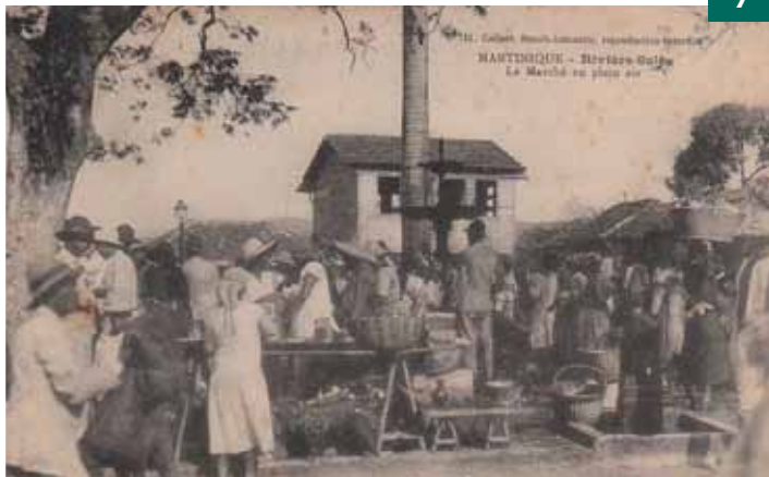
7- Marché en plein air de Rivière-Salée
