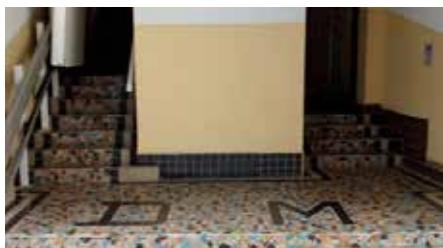
ENTRÉE DE L'IMMEUBLE «ANTILLES» RUE GARNIER PAGÈS
