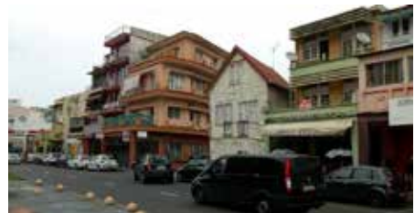
ANGLE RUE JULES MONNEROT ET BYD GAL DE GAULLE – IMMEUBLE BÉTON ET CONSTRUCTION BOIS
