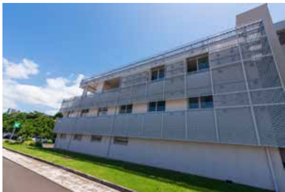
Bâtiment 3 : extension des bureaux de la DAAF Martinique
