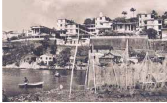
LE FRONT DE MER AU DROIT DU LYCÉE SCHOELCHER À SA CONSTRUCTION
