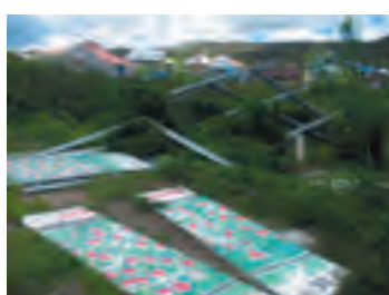
Désordres après le passage du cyclone DEAN
