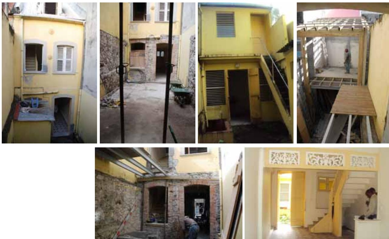
*La parcelle étant très étroite et profonde (3 X 17 mètres environ), le projet consistait, dans un esprit loft, à dégager au maximum les volumes en décroissant les pièces du rez-de-chaussée et en désencombrant l'espace de la cour (démolition de l'escalier, du bassin et du cagibi) afin de créer une continuité visuelle, de la rue, jusqu'en fond de cour.*
