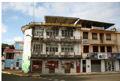
Vue du bâtiment avant sa réhabilitation - Source : http://mapio.net/pic/p-52151566/
