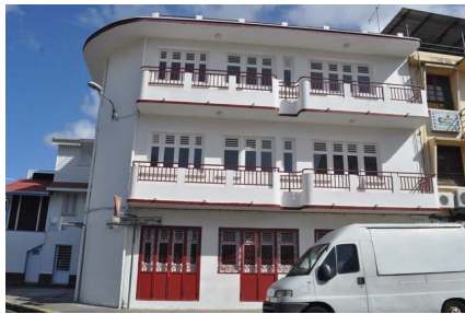
Après réhabilitation - crédit photo CAUE
