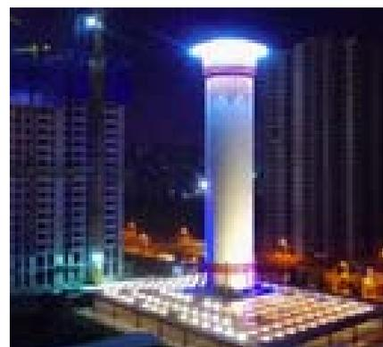
La ville de Xi'an (Chine) a édifié une tour filtrante qui permettrait de nettoyer l'air urbain en capturant les particules fines, comme le ferait un purificateur d'air géant. Ce test reste toutefois à démontrer. Il s'agit d'une structure de 60 mètres de haut, localisée dans une concentration de gratte-ciels de Xi'an où l'air est fortement pollué.
