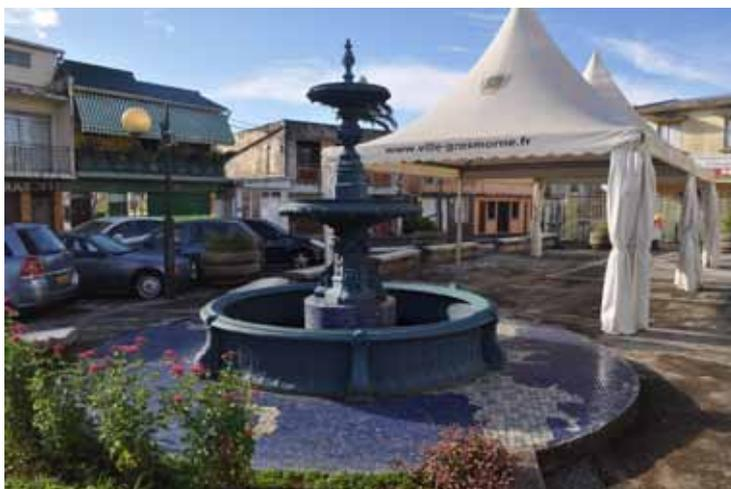
L'ensemble repose sur un socle récent en maçonnerie revêtu également de céramique bleue. La fontaine mesure 2,50 m de haut. Son bassin est profond de 52 cm pour un diamètre de 2,80 m.
